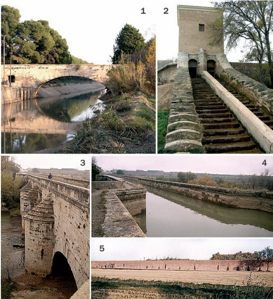
8.9. El Canal Imperial de Aragón: 1) Puente de Formigales (Navarra); 2) Almenara de desagüe al Jalón denominada de San Martín, con treinta gradas; 3-4) Acueducto del Jalón (obsérvese el estrechamiento del canal sobre el acueducto, para reducir la fábrica), formado por cuatro arcos de medio punto de 8,30 m de luz; 5) La muralla de Grisén. (Fot.: M.S.S.)
