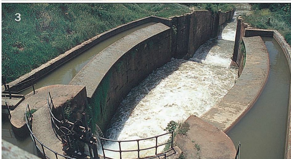
8.11. El Canal de Castilla en la provincia de Palencia: 1) Puente típico, cerca de Osorno (obsérvese el camino de sirga); 2) Acueducto de cruce sobre el río Valdavia; 3) Esclusas (ovales) de descenso al nivel del río Carrión, en La Calahorra. (Fot.: Juan J. Arenas.)
