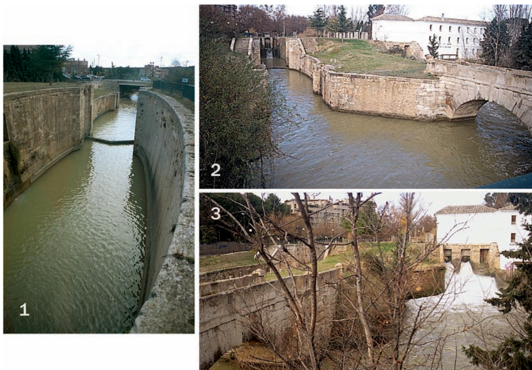
8.10. El Canal Imperial de Aragón en Zaragoza: 1) Esclusas (ovales) de San Carlos; 2-3) Las esclusas, puente y edificio (almenara y antiguamente con molino harinero de cinco muelas y batán con ocho pilas; hoy existe una central hidroeléctrica); bajo el puente se reintegran al canal las aguas que no fluyen a través de las esclusas. (Fot.: M.S.S.)
