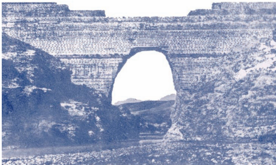
8.12. Vista parcial de la presa dieciochesca del Estrecho de Puentes. Su construcción dio lugar a una terrible riada en 1802, cuando se rompió por sifonamiento. (Fot. del siglo XIX; tomada de N. SMITH, 1992.)
