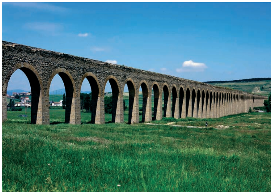
8.13. Acueducto de Noáin, diseñado por Ventura Rodríguez, 1780-93. (Fot.: Revista de Fomento.)
