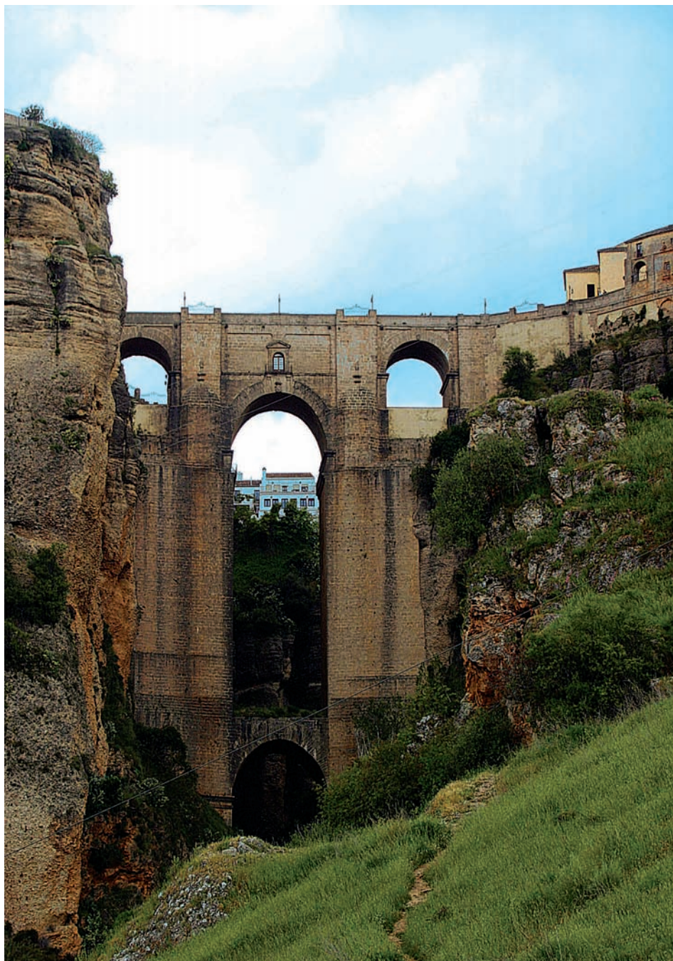
8.7. Puente sobre el Tajo de Ronda. Arquitecto José Martín Aldehuela. De fábrica con tres bóvedas de cañón, tiene una longitud total de 63 m y luz libre de 14 m en su arco central y 10,5 en los laterales. (Fot.: Revista de Fomento.)
