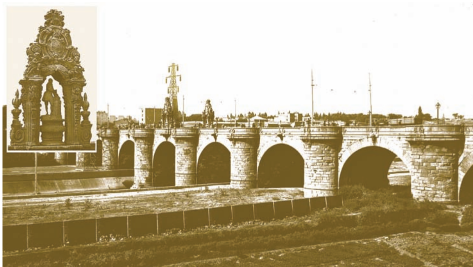
8.6. Puente de Toledo sobre el Manzanares en Madrid (Pedro de Ribera, 1717-1735); detalle con suerte de hornacina perforada e imagen de San Isidro, patrón de Madrid. (Fot.: Arturo González Nieto, h. 1918.)
