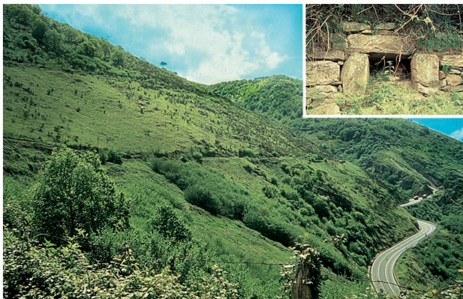
8.1. Carretera ochocentista de Reinosa a Santander, realizada por Marcos de Vierna entre 1749-1753: 1) Restos del trazado original; 2) Detalle de obra de drenaje. (Fot.: Rafael Ferrer Torío.)
