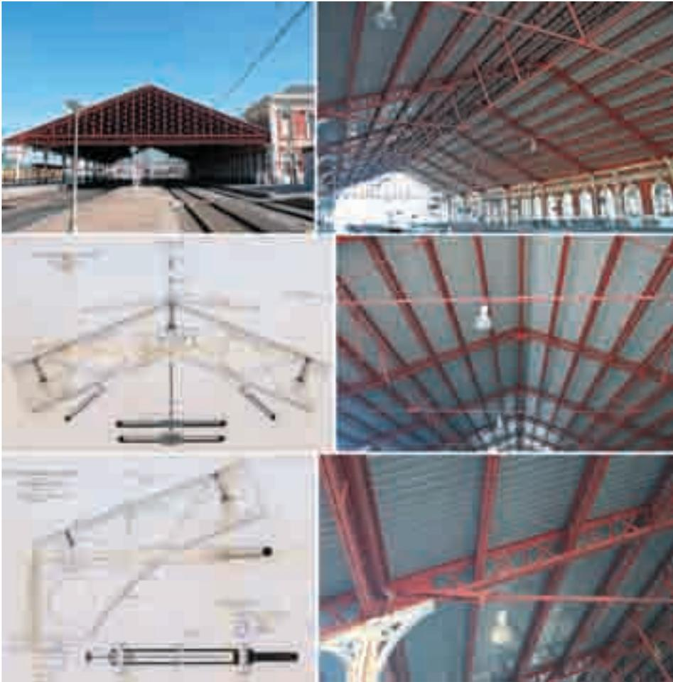
**9.9. Estación de Medina del Campo:** 1) Vista frontal; 2) Cerchas Polonceau y arriostramiento longitudinal; 3 y 4) Dibujo y realización de los nudos de coronación; 5 y 6) Dibujo y realización de los enlaces entre el tirante y la viga principal de las cerchas Polonceau.
