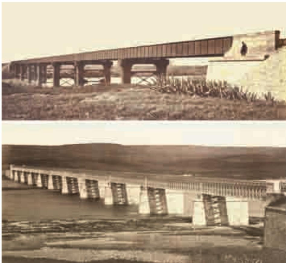
**10.20. Puentes de vigas:** 1) de alma llena de Lora del Río, sobre el Guadalquivir, en la línea de ferrocarril de Córdoba a Sevilla (fot.: J. Martínez Sánchez); 2) en celosía, D. Álvaro, sobre el Guadiana, en Mérida, en la línea de ferrocarril de Ciudad Real a Badajoz. Empresa constructora M. Parent y Schaken, 1866 (fot.: J. Laurent). (Fuente: VV. AA., Puentes de hierro, 1878b).
