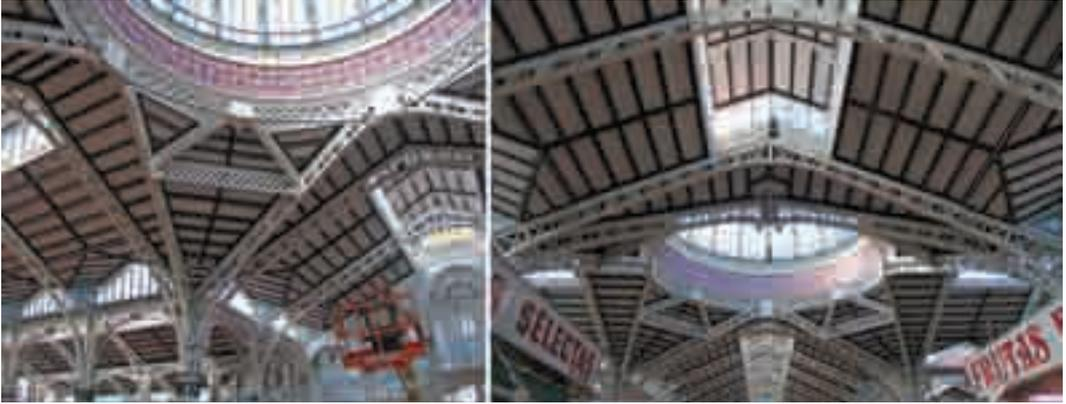
**9.17. Mercado Central de Valencia:** 1) Interior; 2) Formidable resolución del sostén de la cúpula y el enlace de su estructura con las naves principales y del crucero, soportado por pórticos transversales triangulados y articulados en la base.
