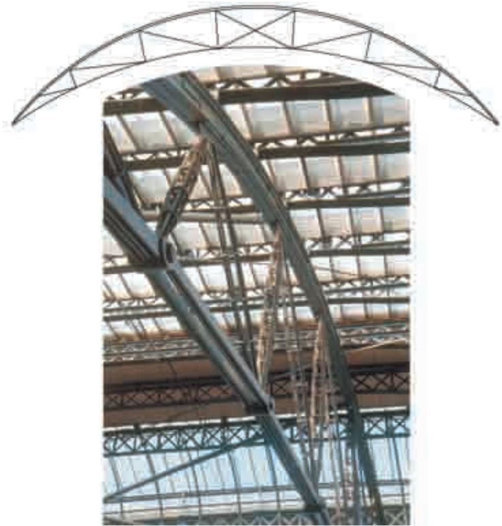
**9.4. Cercha biapoyada en celosía de la Lime Street Station, con luz de 50 m (1850):** Richard Turner, diseñador con Joseph Paxton del Crystal Palace de Londres, construyó esta formidable viga, totalmente articulada y que eliminaba la fea apariencia (entonces) de los tirantes metálicos de las cerchas Polonceau. Una realización realmente formidable.
