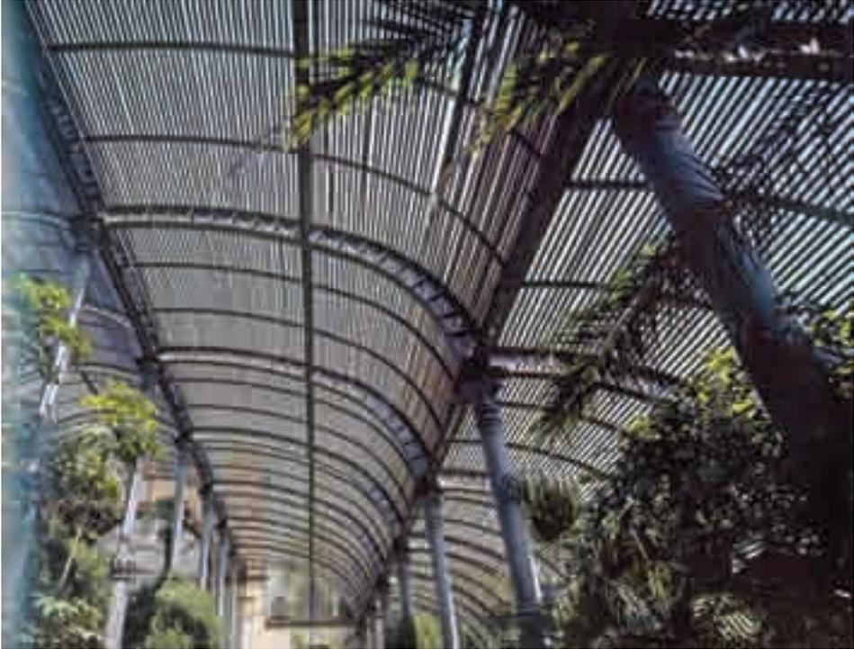
**9.20. Invernadero en el parque de la Ciudadela de Barcelona (1888):** Preciosa estructura que va bajando los empujes horizontales de bóveda cilíndrica en bóveda cilíndrica.
